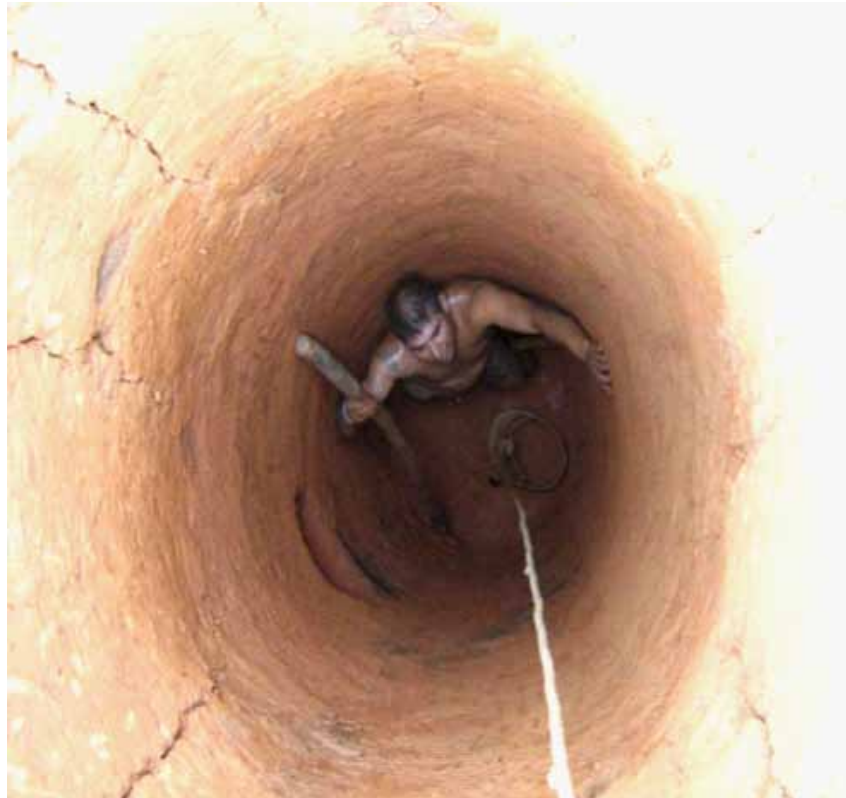
Excavando pozo y construyendo futuro (Fuente: Raúl Cháves)
